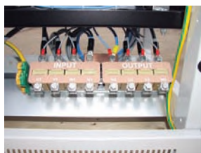
Oberon Y45-15: клеммная колодка для силовых кабелей
