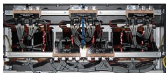
Вольтодобавочные трансформаторы
