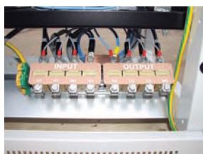
Oberon Y45-15: тороидальный вариатор, вольтодобавочный трансформатор
