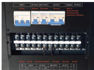
Power-Vision Black 3/1 10 кВА клеммная колодка для силовых кабелей, автоматы управления
