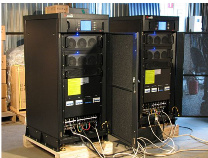
Параллельная система 2x40 кВА - Power-Vision HF
