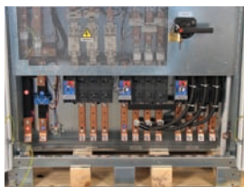
Клеммная колодка для подключения кабелей
